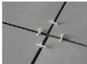
En croix. Pour un écartement constant et un alignement parfait des carreaux avec des joints réguliers et homogènes. En PS Choc rigide. Couleur jaune. *(jetable, invisible sous le joint).*
